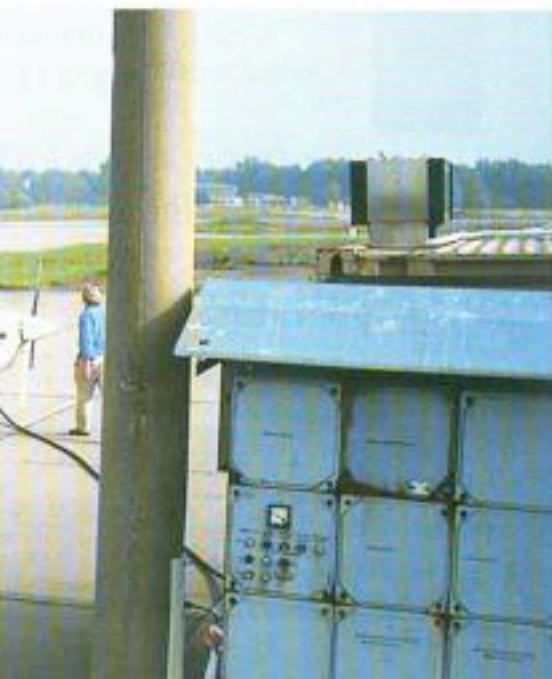
Op Peenemünde staat de PH-FEA tussen stoppenkasten: external power voor de MiG's die hier vroeger stonden.
